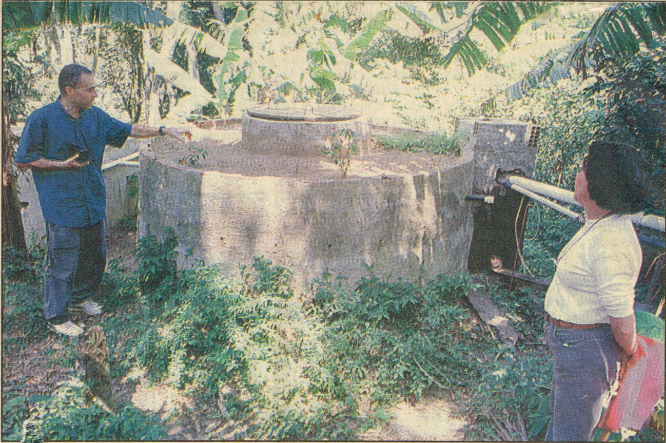
Os biodigestores permitem que o esgoto, depois de tratado, volte limpo para o curso do rio.
