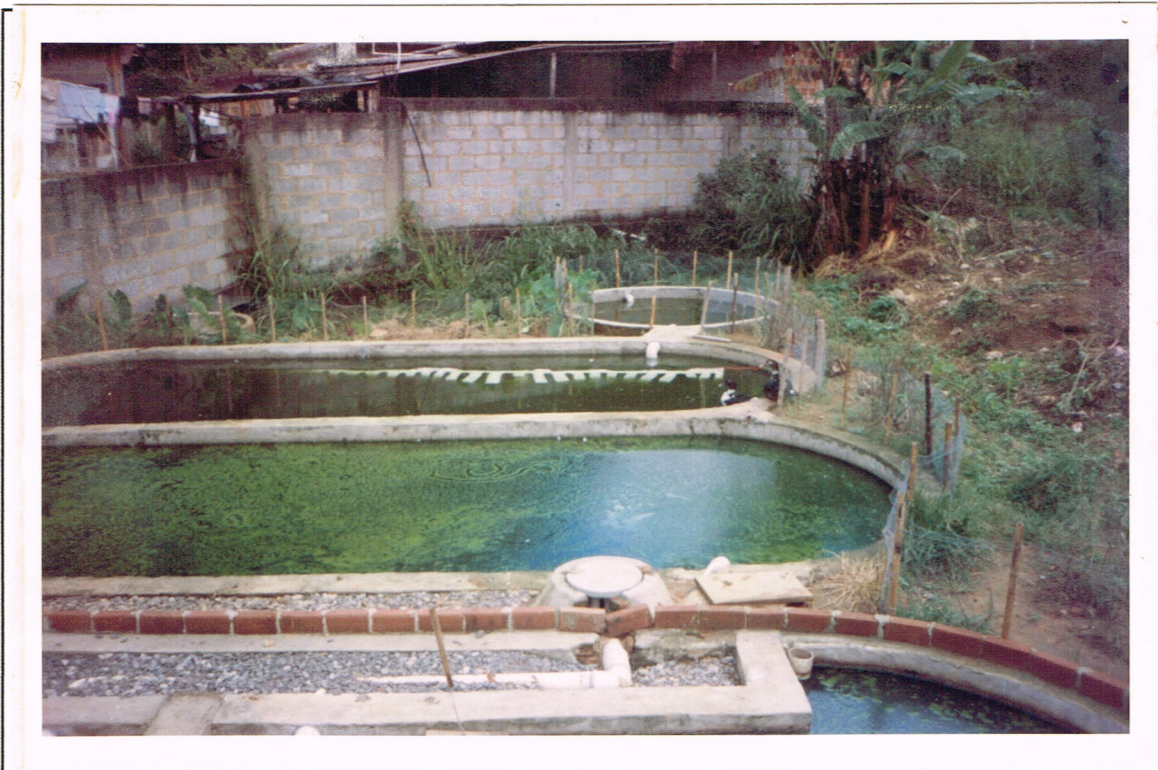
Tanque de Macrófitas da Estação; ao fundo, filtro biológico para absorção de material em suspensão Station Macrophytes Pond; on the back, biological filter to absorb the suspension material
