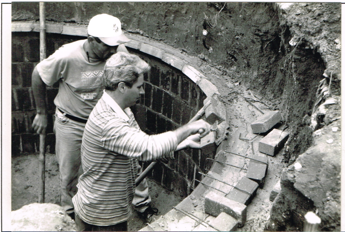
Construção do primeiro Biodigestor supervisionada por técnico do OIA Building of the first Biodigester supervised by a specialist of OIA
