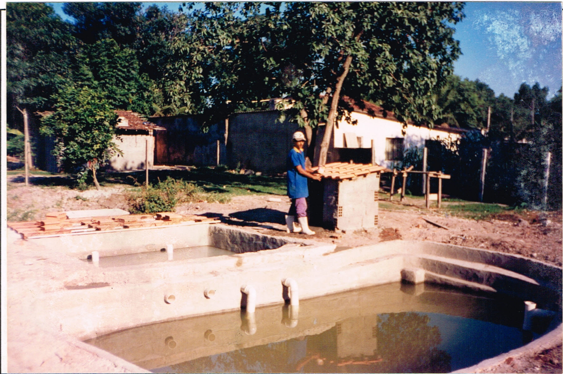
Tanque de Macrófitas acoplado ao Biodigestor implantado no Centro Social "Creche-Abrigo Lar de Vasti", na comunidade de Vila Angélica-Caxias Macrophytes Tank articulated with a Biodigester at Social Center: "Creche-Abrigo Lar de Vasti", Vila Angélica Community-Caxias
