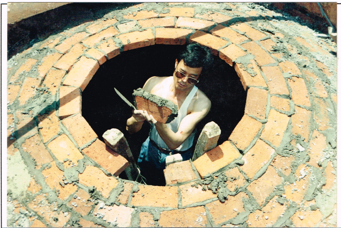
Construção do Biodigestor executada diretamente por técnicos chineses Building of the Biodigester executed directly by chinese specialists
