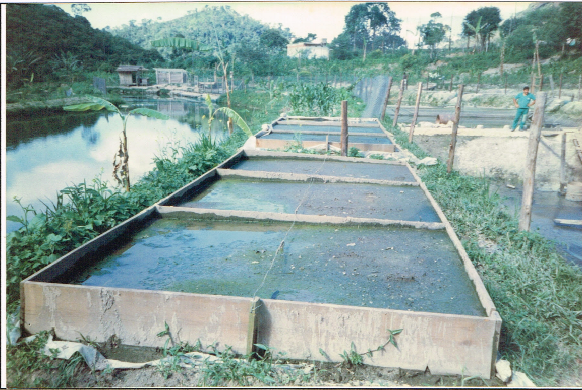
Caixas de secagem do lodo retirado dos Tanques de Oxidação Drying box of the sludge removed from the Oxidation Ponds
